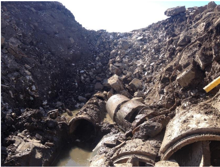
Figur 1. Byte av del av den gamla betongrörledningen som tar emot lakvatten från Ekbackstippen. Foto: Faveo Projektledning, 2013-05-07.
