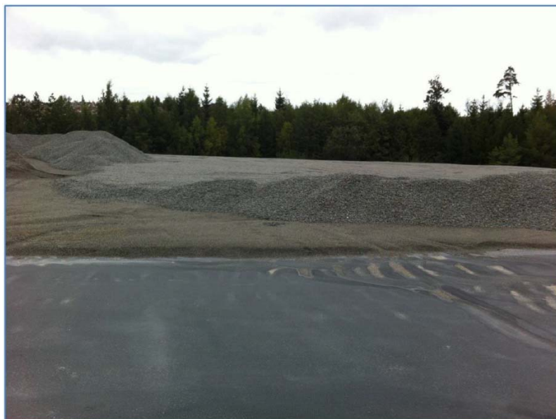
Figur 3. Arbete med sluttäckning, Ekbacken. Tätlager (syntetiskt geomembran) synligt, överlagrat av skyddsskikt av stenmjöl, samt dräneringsskikt av makadam.
