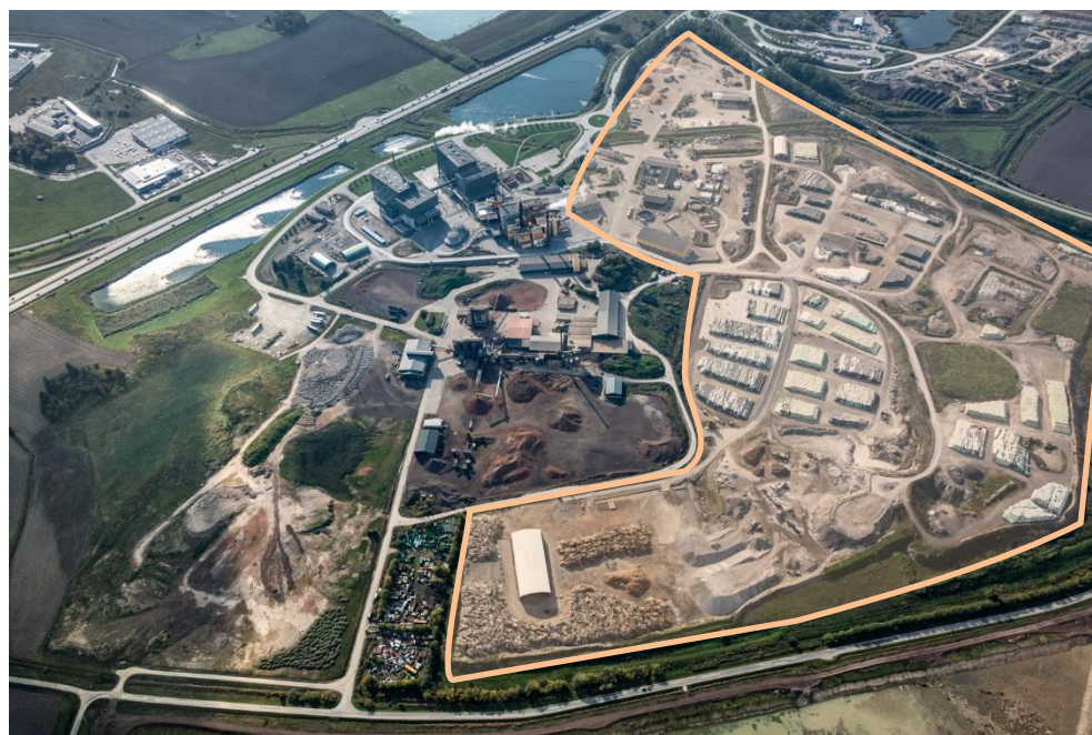
Gärstad avfallsanläggning okt 2017, från nordost.
